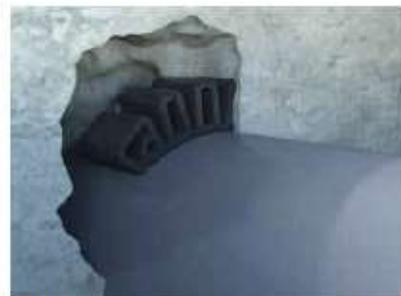
Ancrage du tube dans un mur
