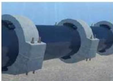
Buter les éléments de lestage d'un tube
